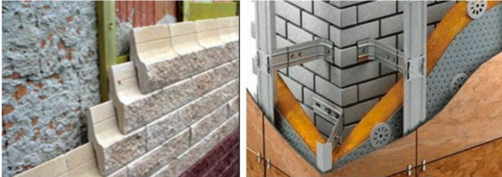
Рисунок 1 – Фрагмент стіни з навісним вентиляваним фасадом.
