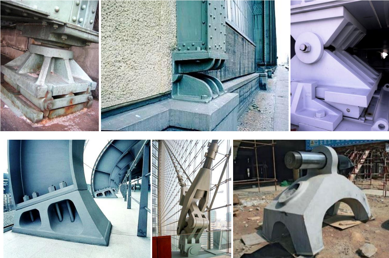
Рисунок 1 - Приклади литих металевих опорних деталей фундаменту.
