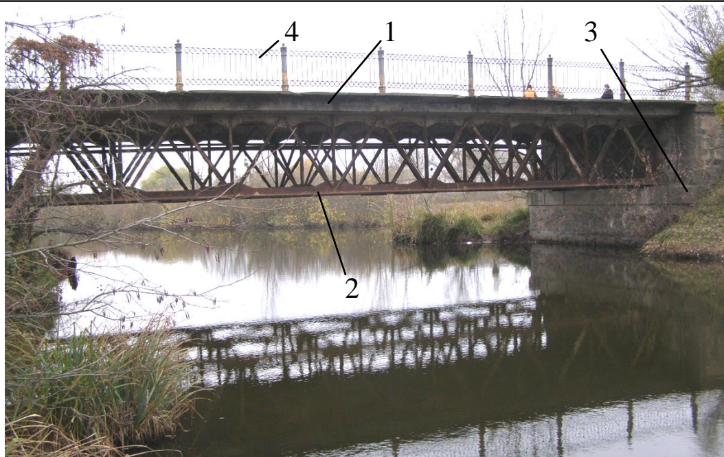
Рисунок 1 – Загальний вигляд сталевозалізобетонного мосту на автодорозі державного значення Р-33 у смт. Дашів до реконструкції. Тут: 1 – залізобетонна двохконсольна прогонова плита, 2 – просторова сталева ферма, 3 – берегова опора, 4 – перильне огородження.
