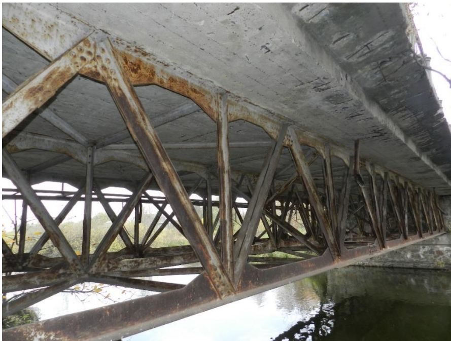
Рисунок 3 – Конструкція прогонової будови мосту на дорозі Р-33 у смт. Дашів у вигляді просторової ферми з накладною двохконсольною залізобетонною плитою (вид знизу).
