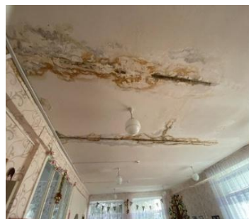
Рисунок 7 – Замокання стелі другого поверху
