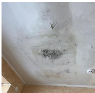
Рисунок 6 – Грибок на стелі другого поверху
