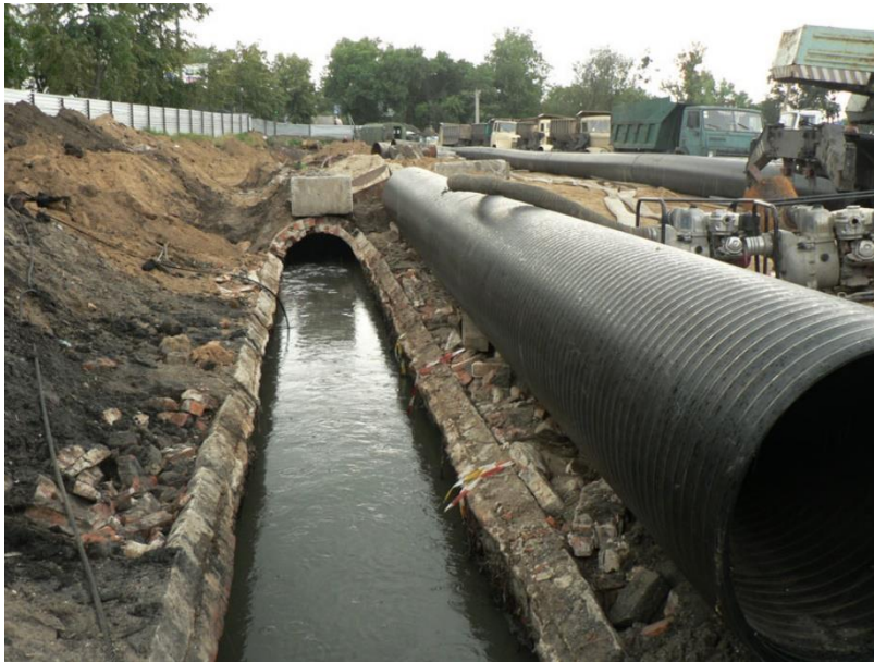
Рисунок 1 – Руйнування колектору каналізації в містах Харків та Суми
