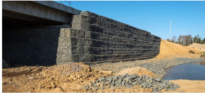
Рисунок 6 – Влаштування габіонних конструкцій
