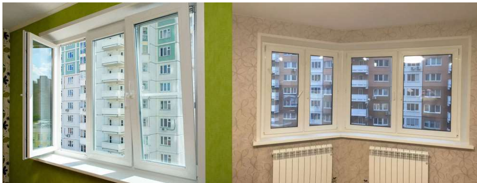
Рисунок 4 – Приклад проблемної інсоляції всередині забудови
