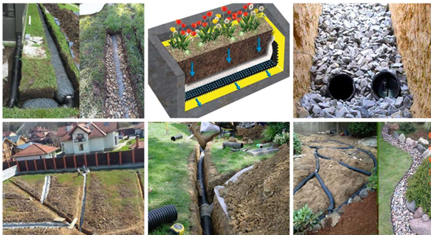
Рисунок 2 - Приклади дренажних систем для зниження ґрунтових вод
