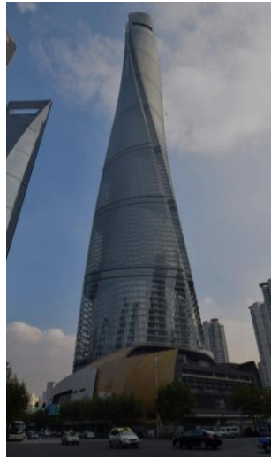
Рисунок 4 – Вежа Шанхая закручується по всій висоті, зводячи до мінімуму зрив потоку
