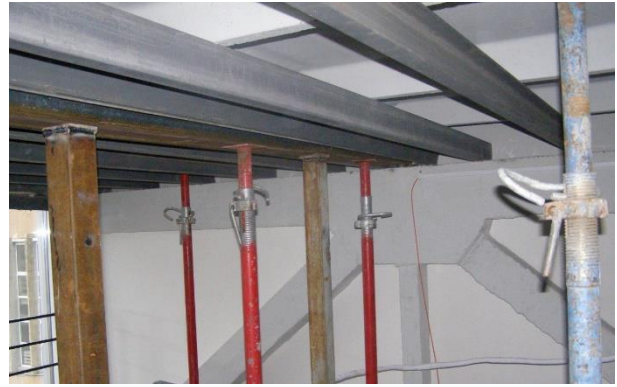
Рисунок 7 – Встановлення страхувальних телескопічних стійок. Улаштування поздовжніх компактних сталевих балок підсилення у зазорі між поперечними ребрами аварійних плит покриття та фермами покриття
