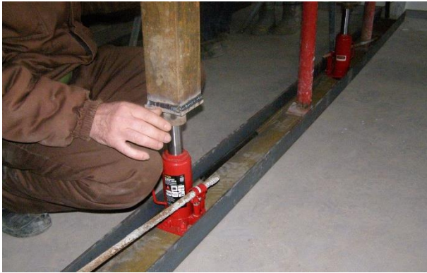
Рисунок 6 – Вирівнювання та розвантаження конструкцій аварійних плит покриття системою з трьох гідравлічних домкратів вантажопідйомністю 20 т кожен
