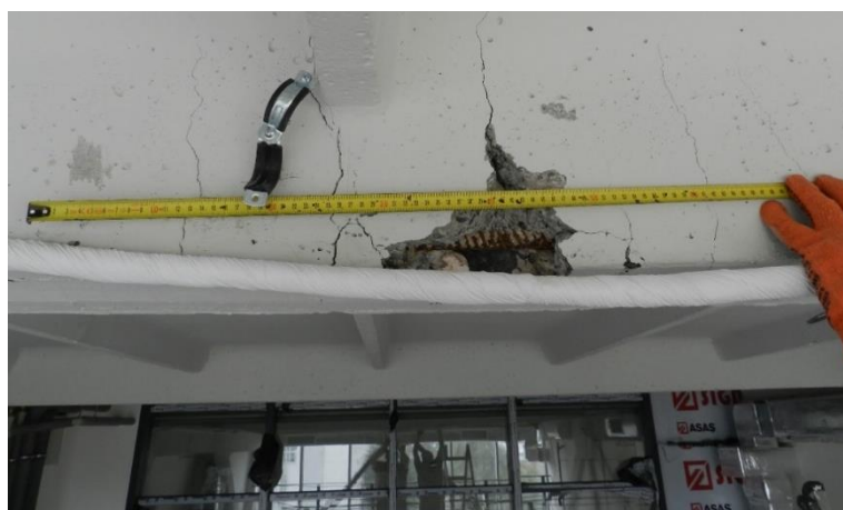
Рисунок 2 – Зовнішній вигляд та технічний стан дефектних ребристих плит покриття: руйнування тіла бетону в центрі прольоту повздовжнього ребра плити з оголенням арматури, наскрізні вертикальні силові тріщини на ділянці більше 0,5 м, понаднормативні прогини плити
