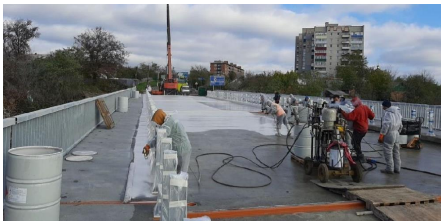
Рисунок 8 – Нанесення водотривкого шару гідроізоляційної мембрани Eliminator
