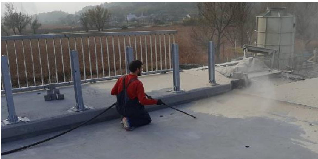
Рисунок 6 – Піскоструминне очищення та знепилення поверхонь під ізоляцію
