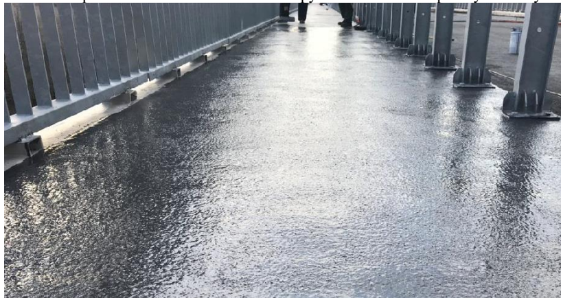
Рисунок 10 – Нанесення верхнього антислизького шару покриття Safetrack® SC на гідроізоляційну мембрану тротуарної частини мосту
