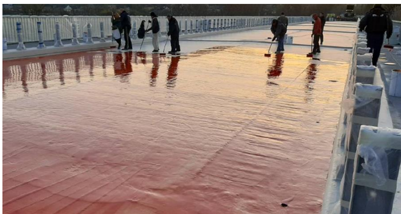
Рисунок 9 – Нанесення термоклеючого зчеплюючого шару Bond Coat 3 на проїзну частину монолітної плити
