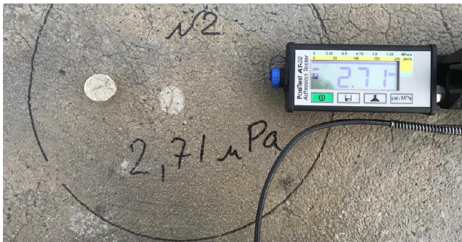
Рисунок 12 – Вимірювання адгезіометром PosiTest AT-M зчеплення ґрунтувального шару до бетонної основи
