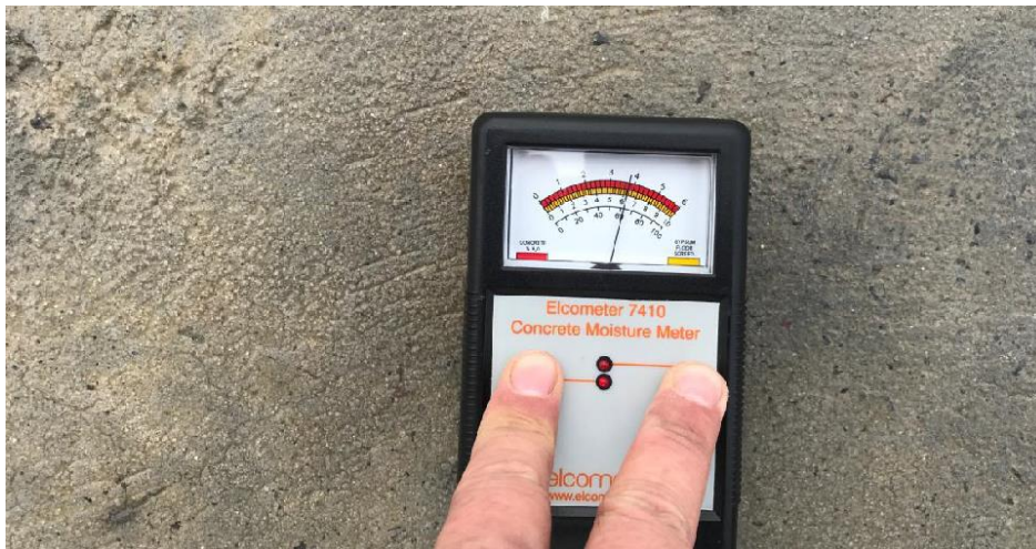
Рисунок 11 – Контроль вологості поверхні бетонної основи перед нанесенням ґрунтувального шару
