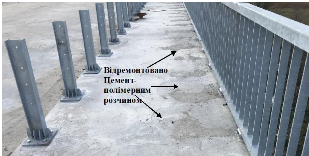
Рисунок 5 – Дефектні ділянки бетонної основи прогонової плити мосту через р. Сіб у м. Гайсин підготовлені під улаштування ізоляції шляхом ремонту згідно з рекомендаціями
