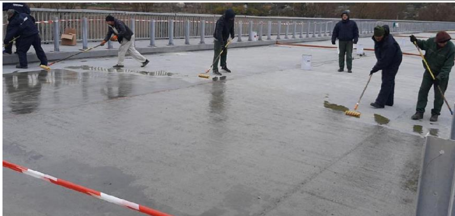
Рисунок 7 – Нанесення ґрунтувального шару PAR 1 Primer
