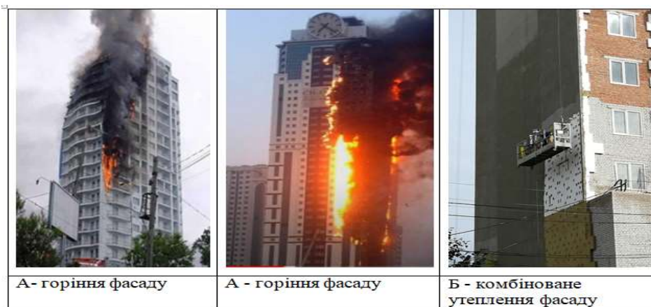
Рисунок 4 – Фрагмент горіння фасаду висотної будівлі утепленої пінополістиролом та комбінованого утеплення з використанням пінополістиролу та мінеральної вати.
