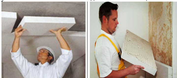
Рисунок 5 – Фрагмент внутрішнього утеплення будинку газобетонними плитами
