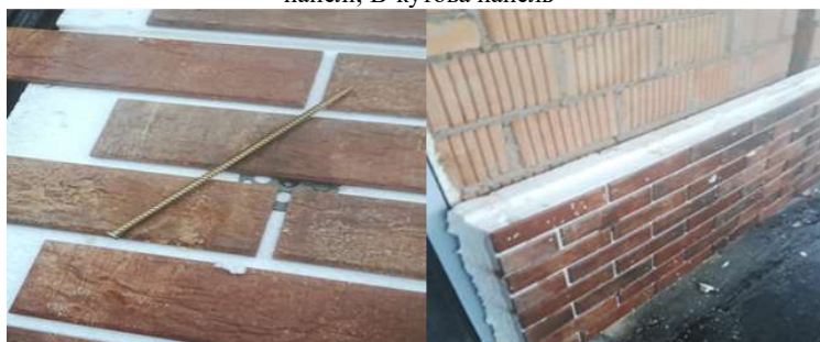
Рисунок 3 – Фрагмент фіксації пінополістирольних панелі до зовнішньої стіни будинку
