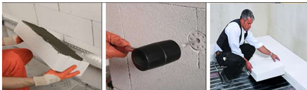
Рисунок 6 – Схема утеплення стін і підлоги житлового будинку
