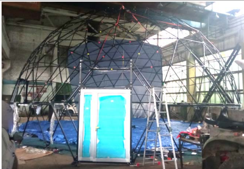
Рисунок 1 – Загальний вигляд каркасу тривимірного проєкційного кінотеатру у вигляді геодезичного куполу фірми ASE Myplanetarium під час виготовлення. Тентове покриття змонтоване частково.
