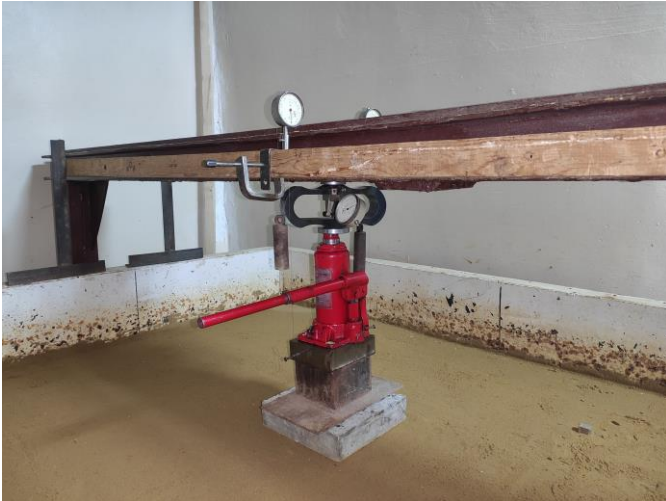
Рисунок 8 – Випробування плити ростверку
