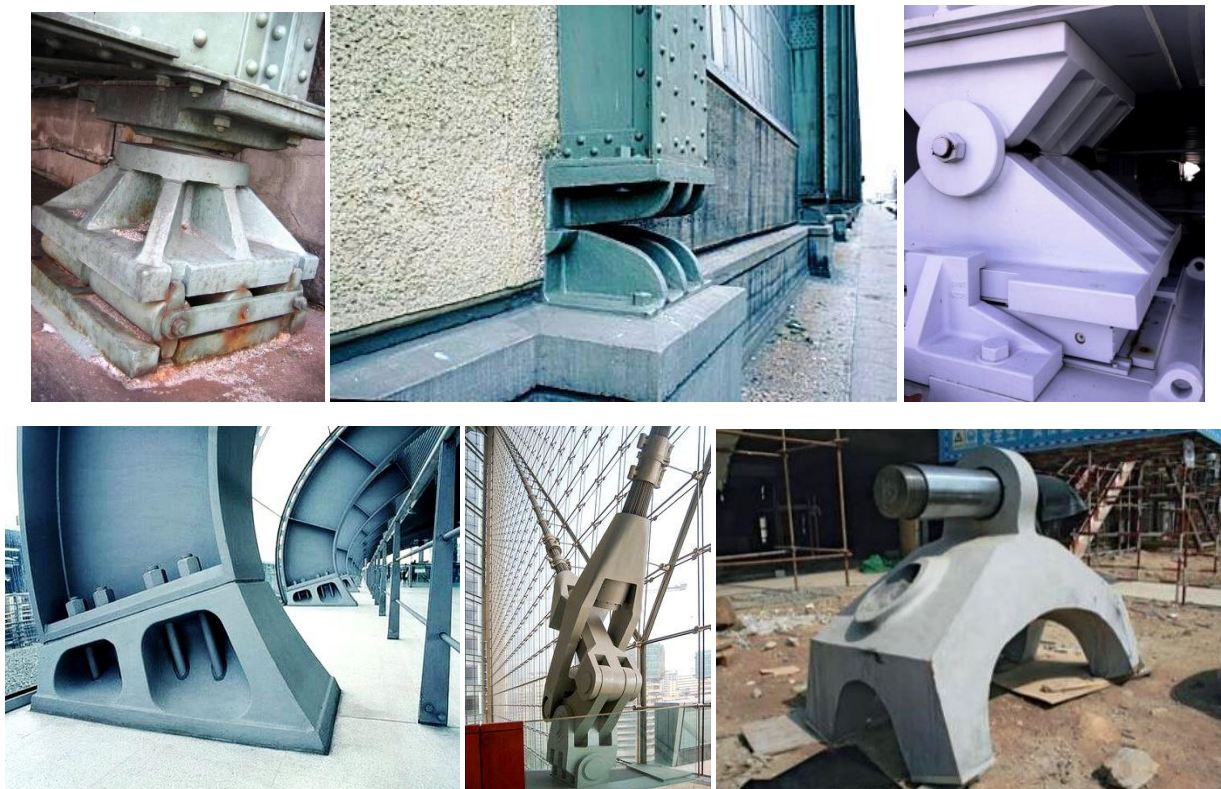
Рисунок 1 - Приклади литих металевих опорних деталей фундаменту.
