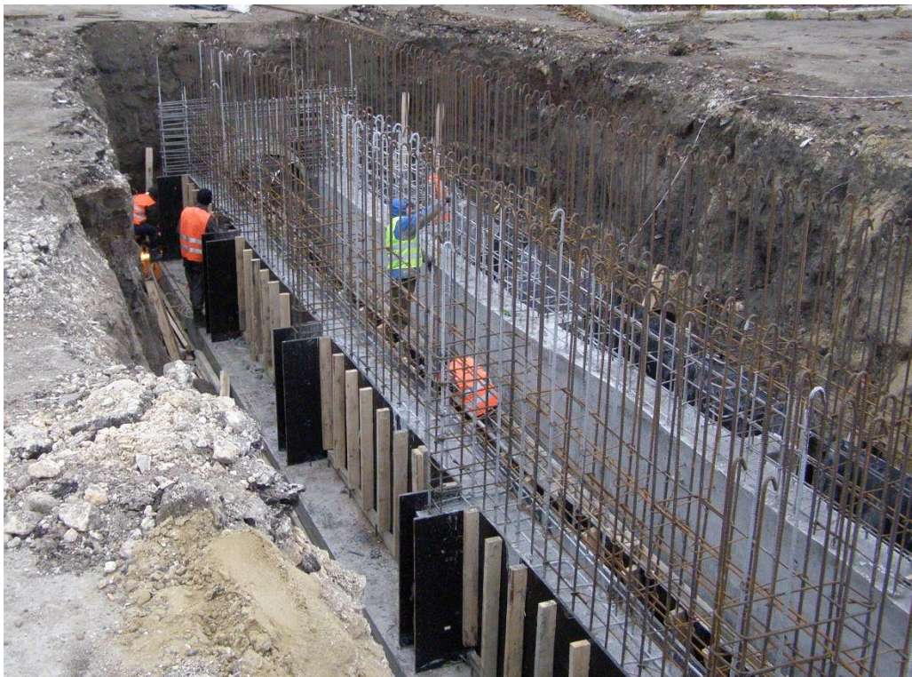
Рисунок 15 – Армування конструкцій тунелю просторовими каркасами.
