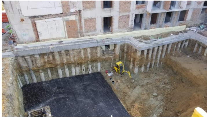
Рисунок 16 – Виконане огородження котловану (листопад, 2021 р.), вид на секції 3, 4
