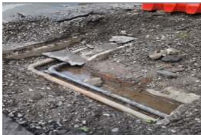
Рисунок 4 - Фрагмент усунення аварії тепломережі по вул. Келецька
