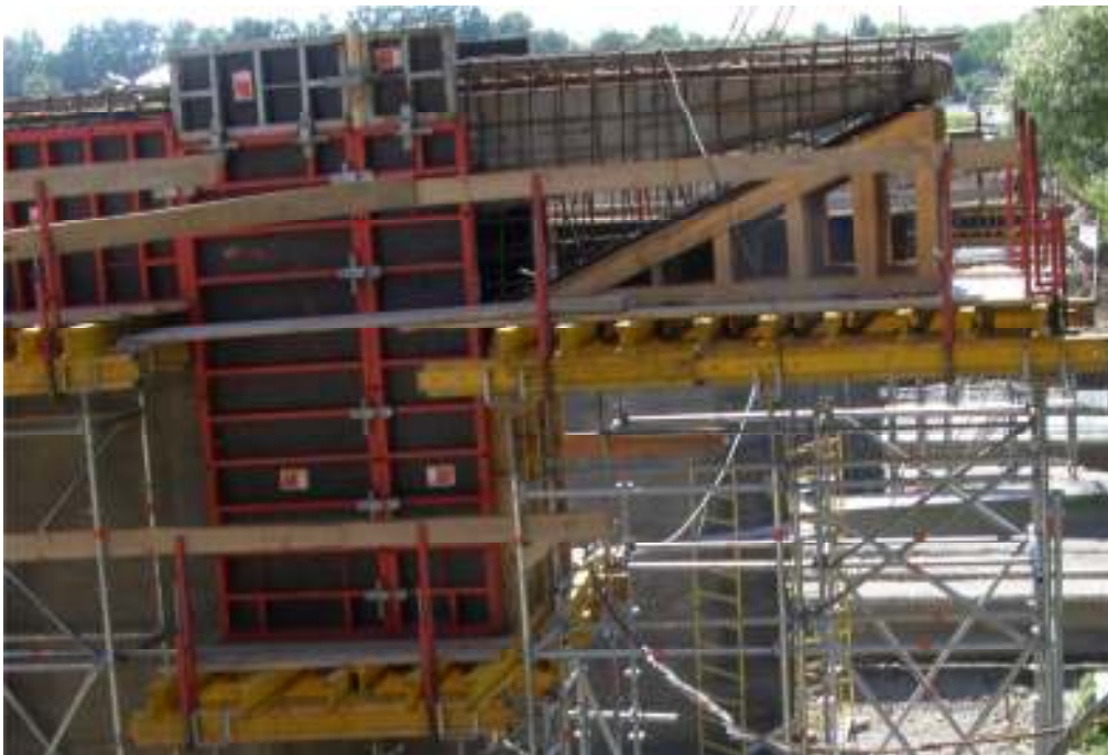
Рисунок 5 – Робоче армування обойми. Встановлення опалубки.
