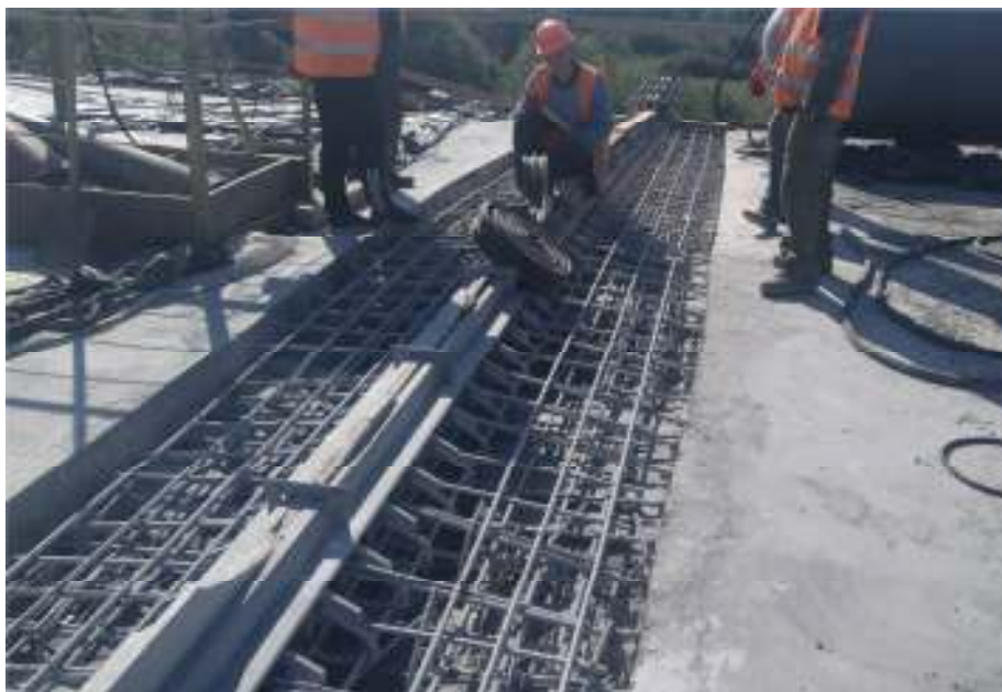
Рисунок 7 – Монтаж металоконструкцій деформаційного шва Mauger D-50 на мостовій споруді у місті Гайсин Вінницької області, що надійно герметизує стик над опорою.
