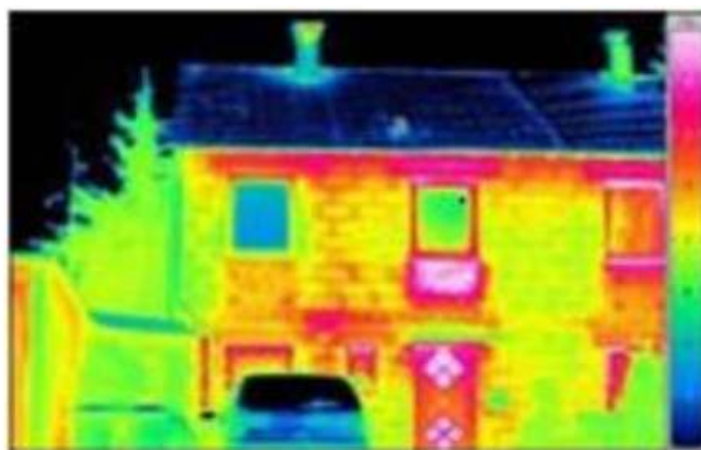
Рисунок 1 – Демонстрація тепловізійних досліджень тепловитратних місць вузлових з’єднань при фасадній системі теплоізоляції з тонкошаровою штукатуркою [13]
