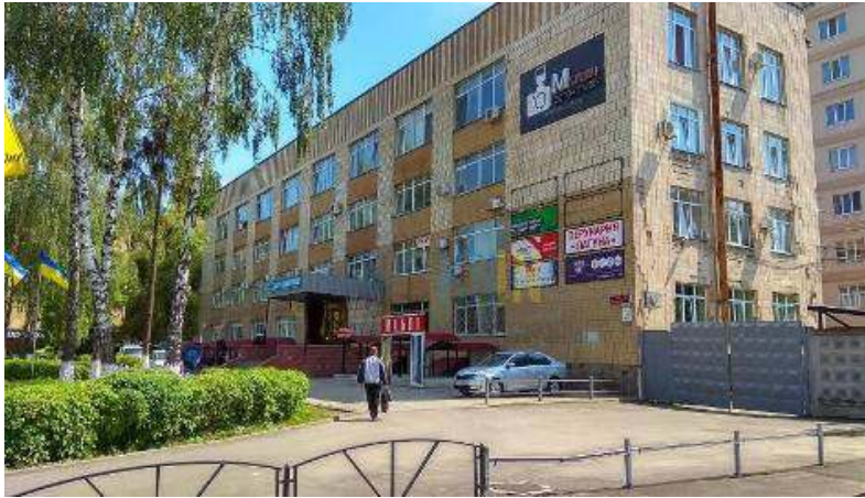
Рисунок 4 – офісна будівля за адресою Келецька,51. м.Вінниця
