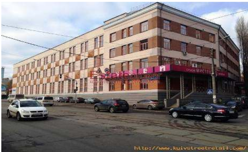
Рисунок 3 – офісна будівля за адресою Глибочецька 17, м. Київ
