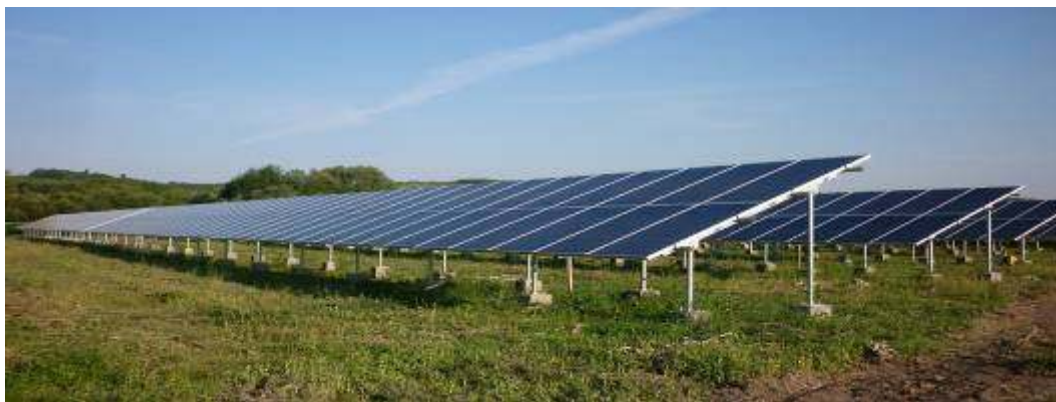
Рисунок 1 – Несучі конструкції для кріплення фотогальванічних модулів
