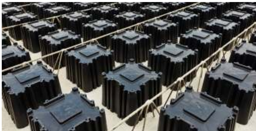
Рисунок 5 – Вкладиші-пустотоутворювачі за технологією Airdeck
