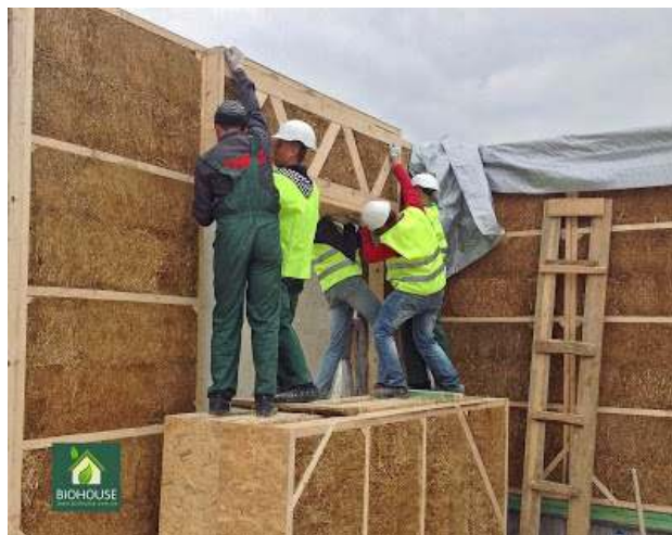
Рис. 4. Солом'яний будинок, що зводиться за каркасно-панельною технологією загальною площею біля 640 м 2 під Харковом [12]
