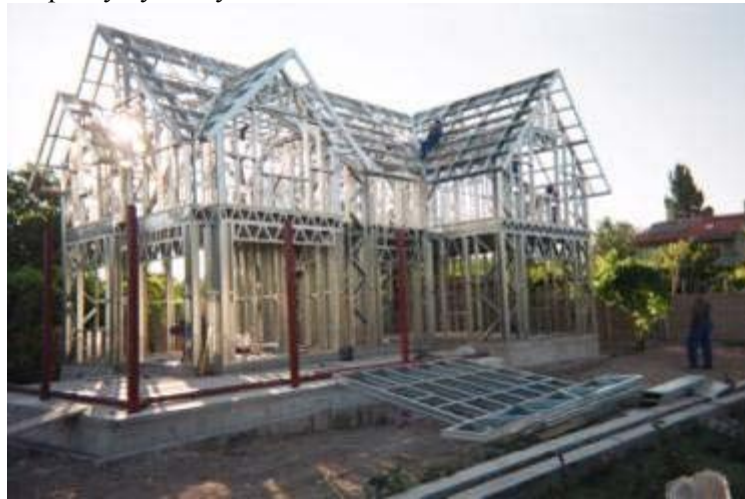
Рисунок 1 – Приклад каркасу будинку з ЛСТК
